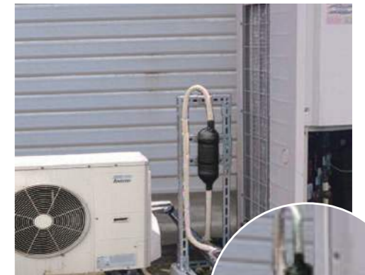
某印刷会社様 空調配管への取付け
